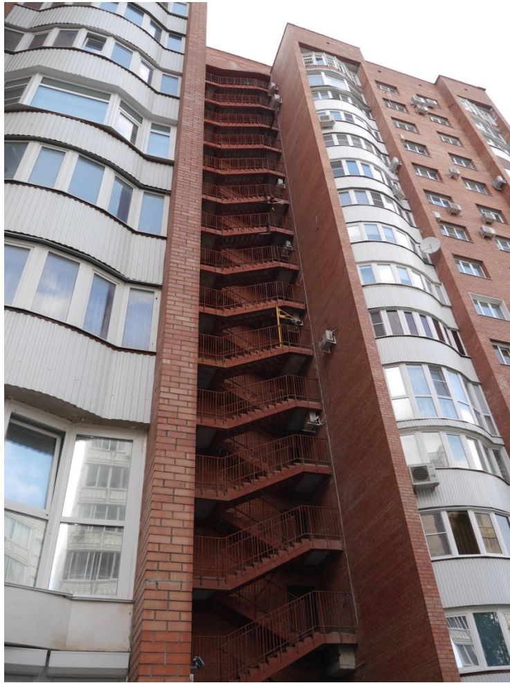
Фото 31 – Общий вид наружной пожарной лестницы в осях «8-11».
