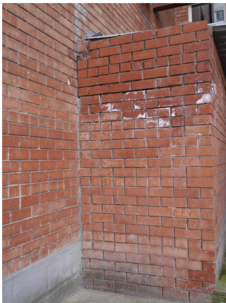
Фото 8 – Замачивание кирпичной кладки входа в подвал в осях 11-8/Т.
