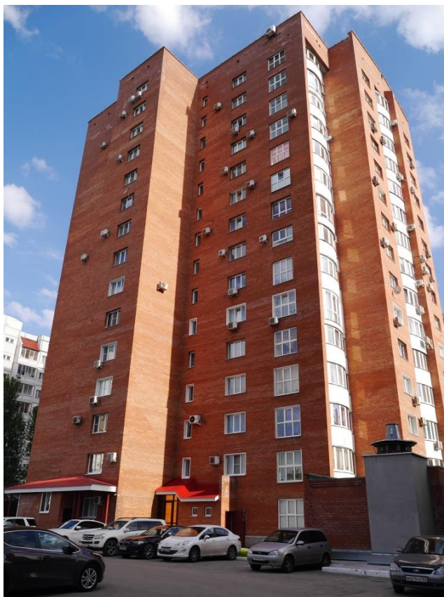
Фото 3 – Фасад обследуемого жилого дома со стороны оси «1».
