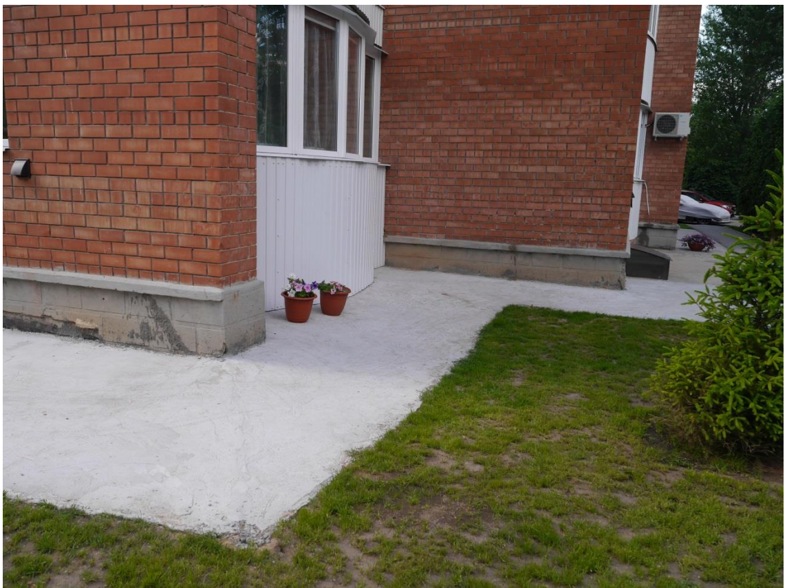
Фото 6 – Участок стены с новой отмосткой и восстановленной гидроизоляцией, в осях 18-20/Ф.
