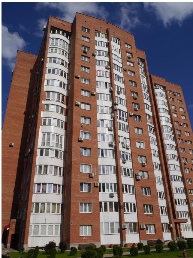
Фото 1 – Фасад обследуемого жилого дома со стороны оси «А».
